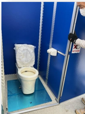
マンホールトイレの中
