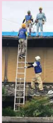
プロボノ(技術系ボランティア)や高所での活動が可能なボランティアによる、屋根上での作業
